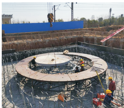
图3 下球铰及滑道安装
