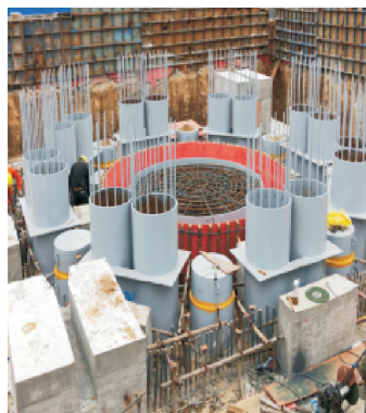
图4 撑脚安装
