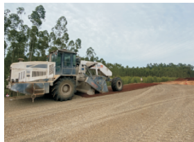
图9 再生冷料路拌机 对混合料拌合
