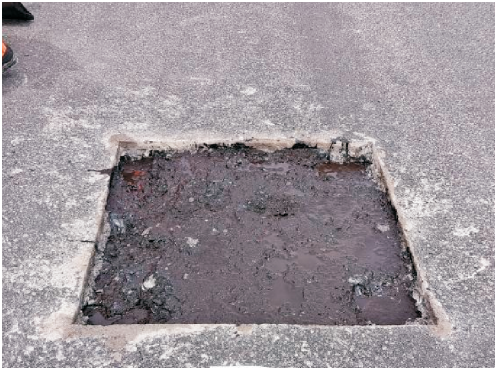
图1 原路面旧料取样图
