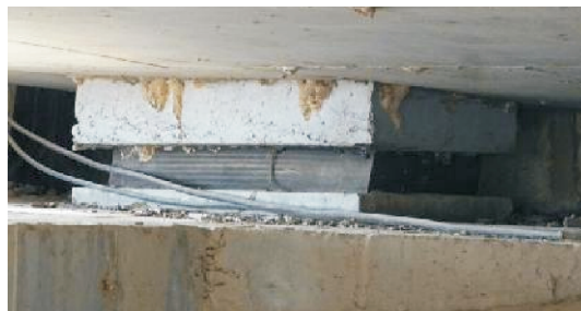
图3 板式橡胶支座现场照片
