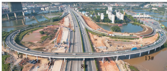
图2 现场顶升改造图
