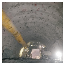
(b) 锚杆+钢纤维混凝土支护
