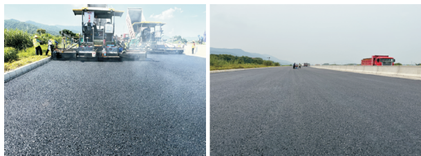
图3 摊铺及碾压完成效果
