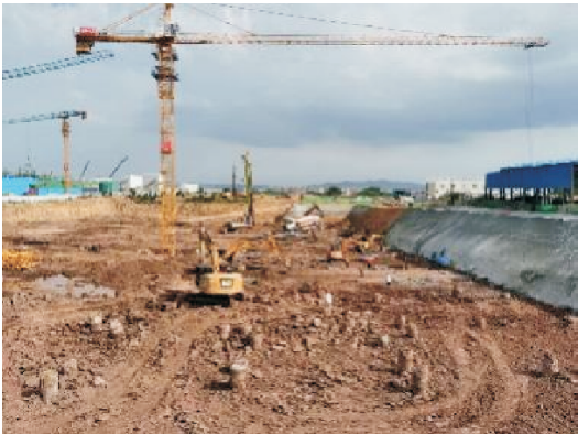
图 1 工程施工现场
