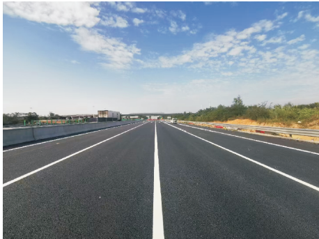
图 1 乳化沥青厂拌冷再生基层路段
