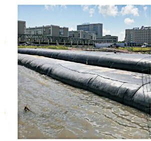
(b) 土工织物管系统外部故障图
