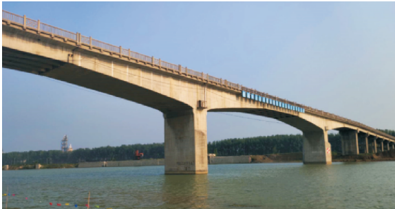
图 1 马兰大桥老桥
