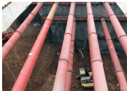
图 2 车站深基坑现场施工图
