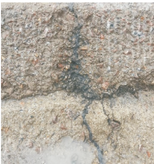
图 8 上、下基层层间脱空位置 水泥浆填充效果
