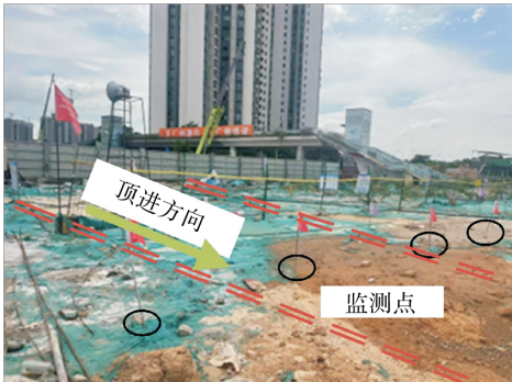
图 3 施工现场监测
