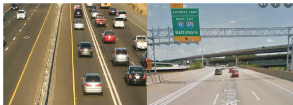
图4 美国六、八车道高速快速车道分隔设置案例
