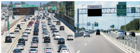
图3 I-495 快速车道弹性示警桩分隔设置
