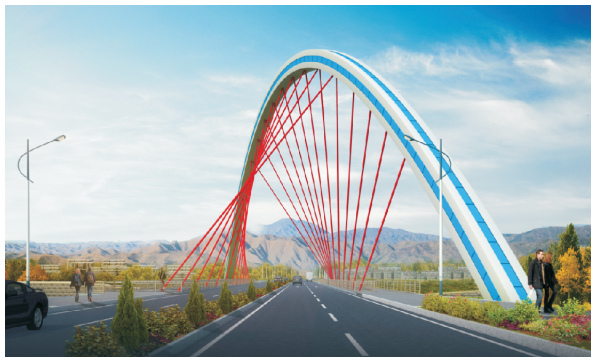
图 1 克兰河大桥单拱斜跨扭转结构图
