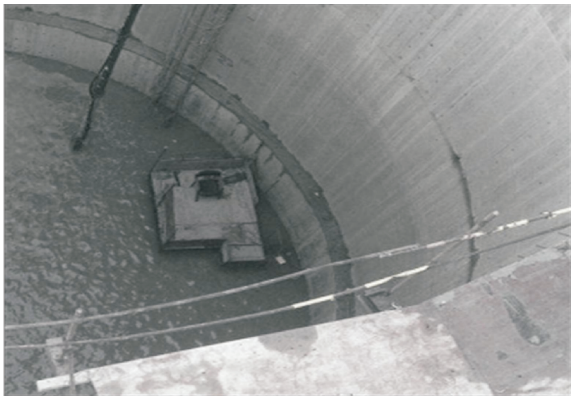
图 2 竖井深基坑施工现场
