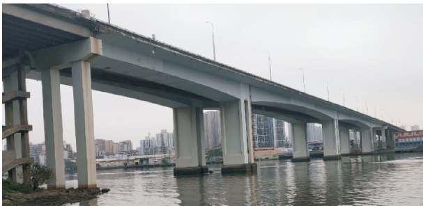
图 1 太平大桥主桥拆除重建前
